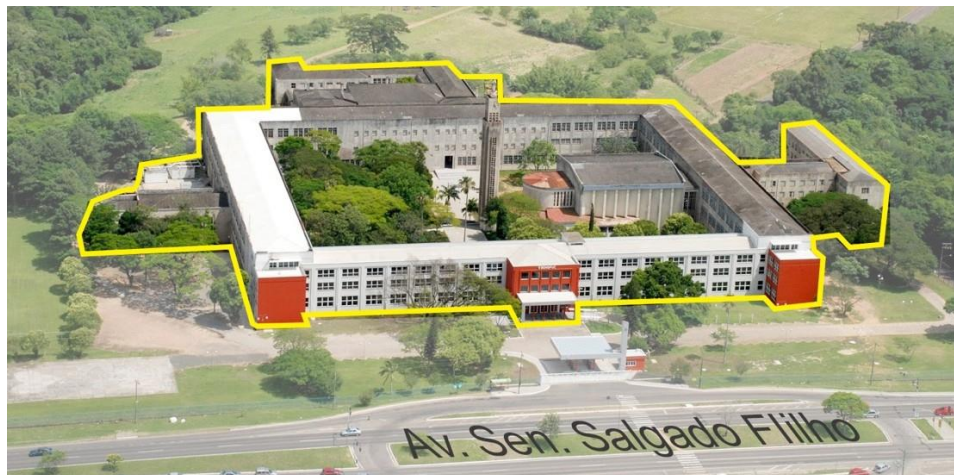
FIGURA 1: Vista aérea do local antes da revitalização
